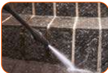
Limpeza de pátios, calçados e terraços
